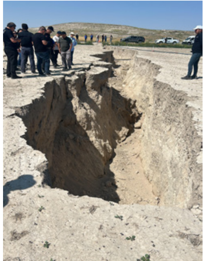
Bei einer durch übermäßige Grundwasserentnahme verursachten Bodenabsenkung entstand auf der Straße zum Kayali-Plateau, Konya (Türkei) ein Spalt – ein Signal für Unumkehrbarkeit und ein Symptom des Wasserbankrotts. Foto: Fatma Canaslan Comut (Juni 2025)
